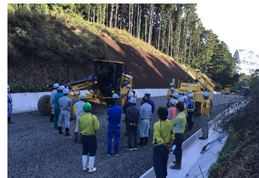
現場見学（ICT建機による施工実演）
