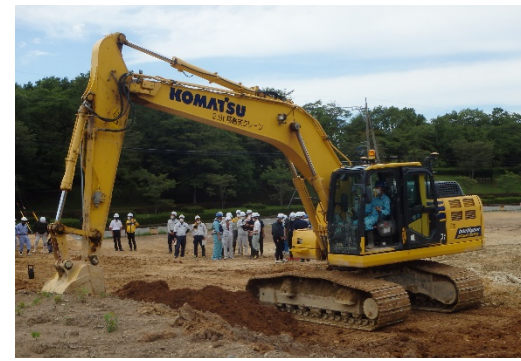
現場見学（ICT建機による施工実演）
