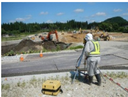
測量機器を使って1点ずつ測量
